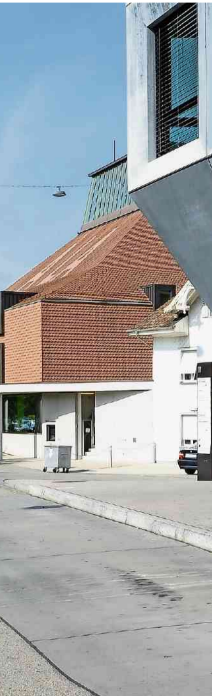
57 Meter hohes Gebäude erstellen. MTO
