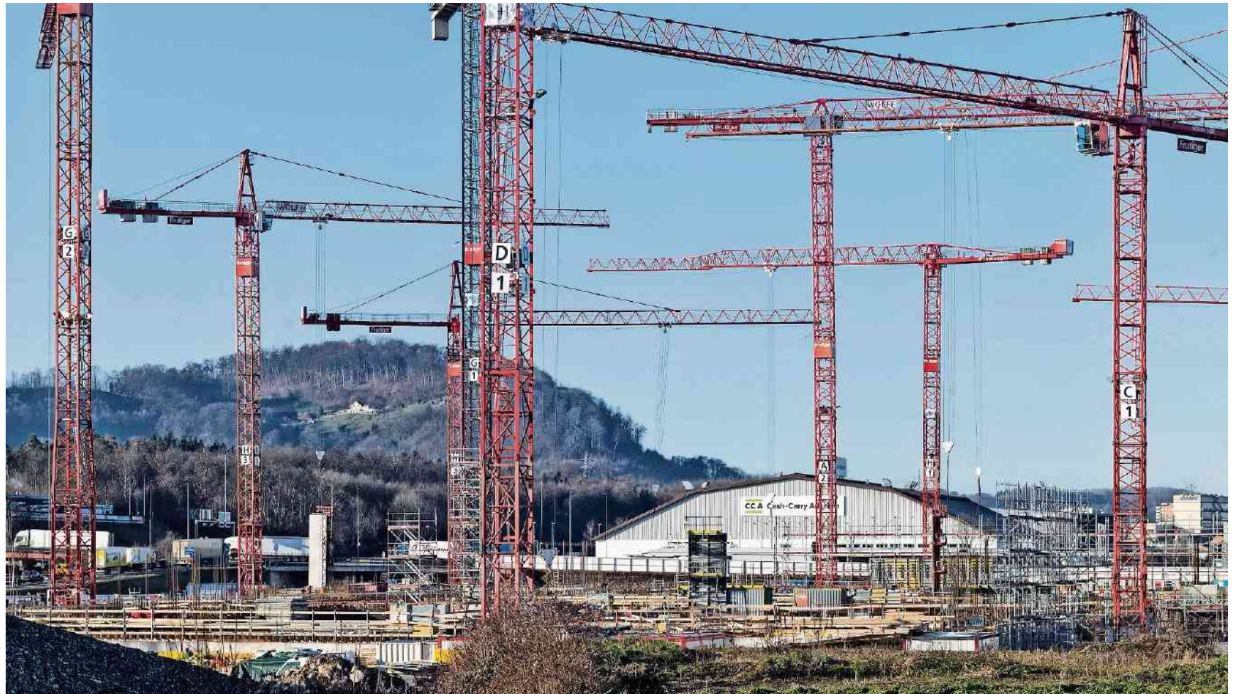
Wächst die Wirtschaft ohne USR III? Solche Fragen sind in den Hintergrund gerückt – die Steuerdebatte dominiert derzeit (Foto: Coop-Baustelle in Pratteln). BZ ARCHIV
