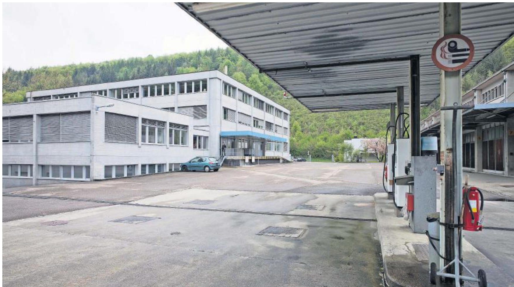
Derzeit arbeiten 50 Angestellte vom Amt für Militär- und Bevölkerungsschutz an der Oristalstrasse 100 in Liestal. Kommt das Asylzentrum, müssen sie weichen.
