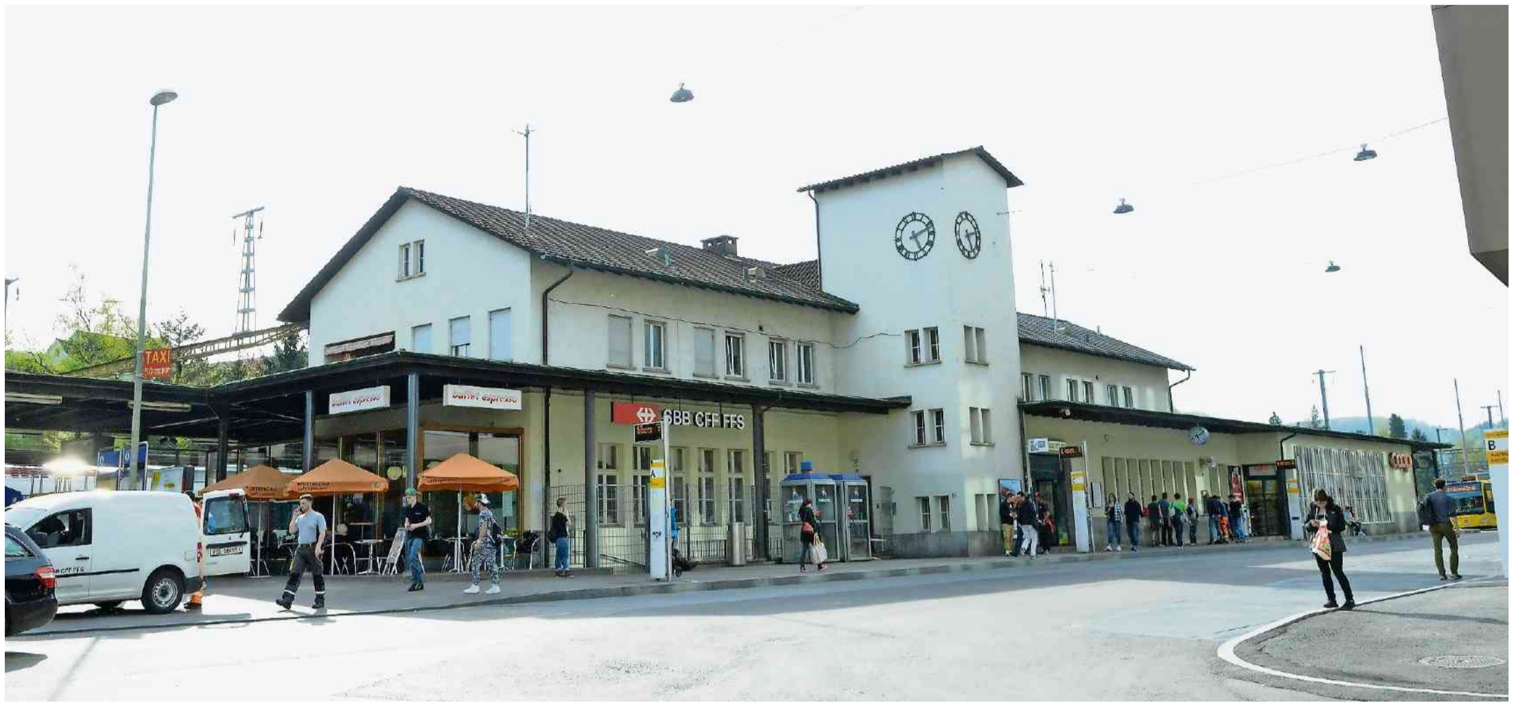
Der heutige Bahnhof in Liestal hat ausgedient. Er wird in den nächsten Jahren abgerissen und soll bis voraussichtlich 2020 durch einen Neubau ersetzt werden.
