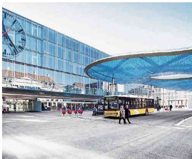
Aarau: Überdachter Vorplatz imponiert.
