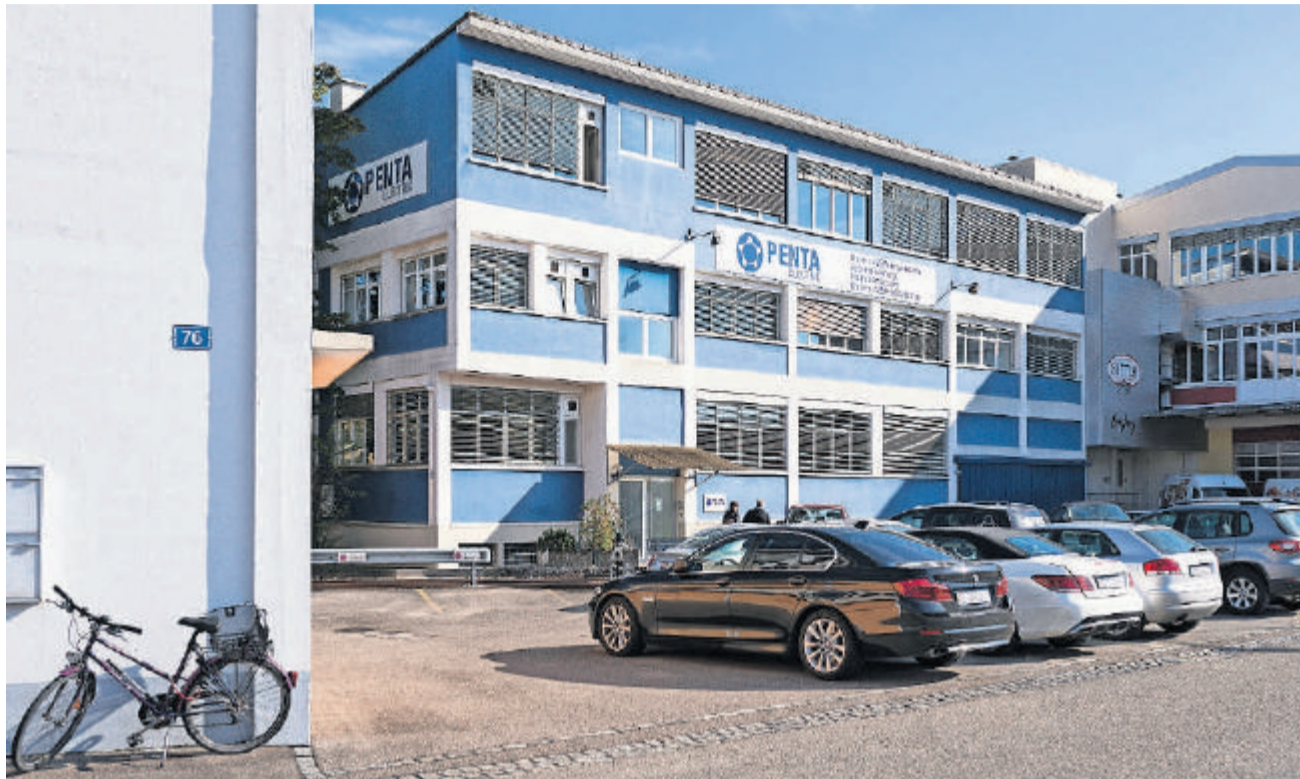
Das heutige Firmengebäude am Dreispitz ist für die Penta-Electric zu klein geworden.
