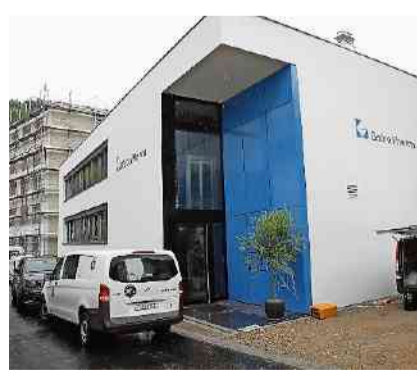
Neubau der Gebro Pharma in Liestal HI
