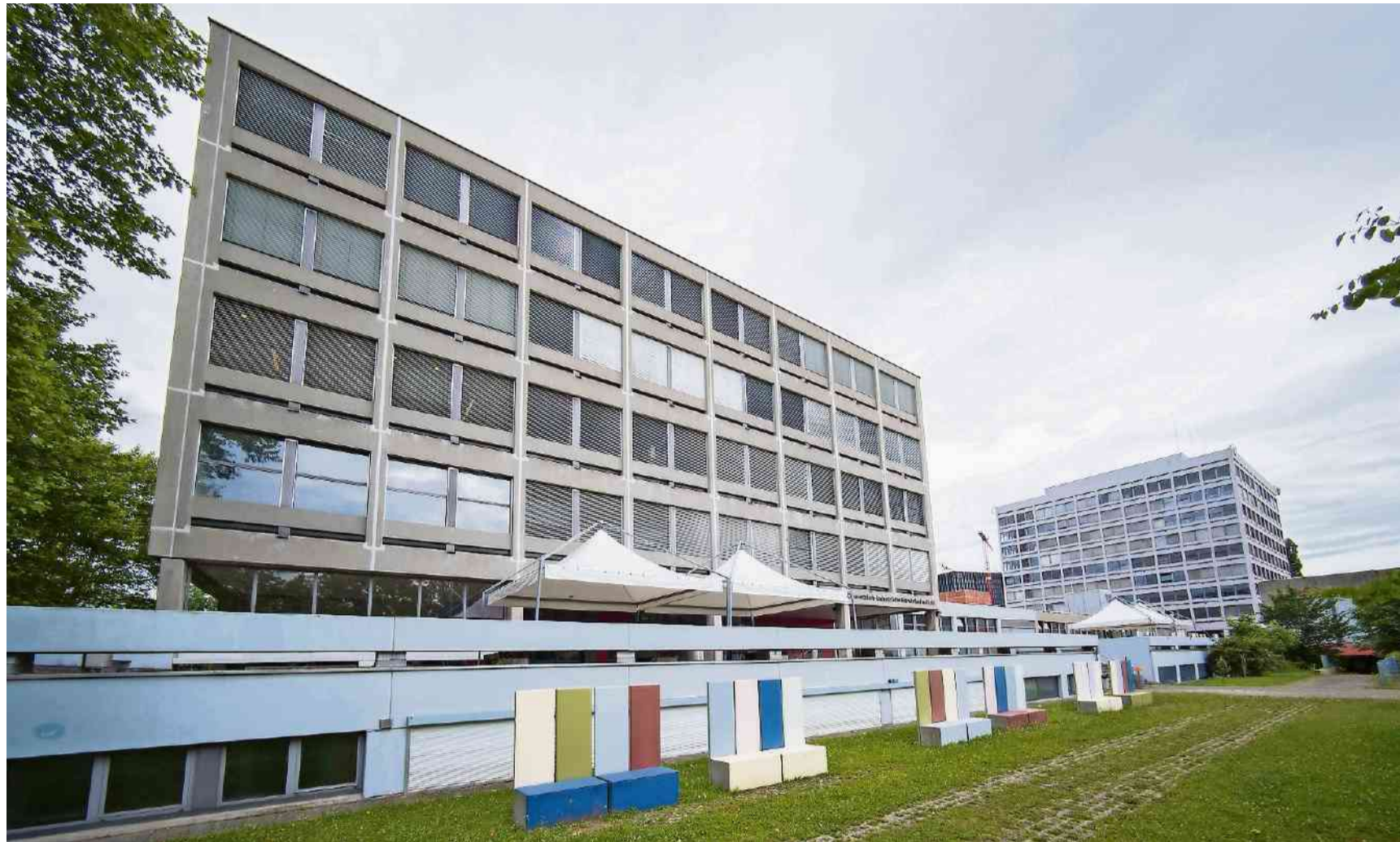
Innere Verdichtung: Auf dem bestehenden MuttENZer Schul-Campus mit Gewerbeschule (links) und FHNW-Altbau hätte es noch Platz für An- oder Neubauten. KEN
