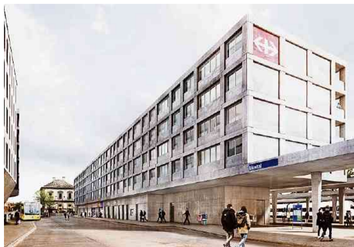
Das zweitplatzierte Projekt der Basler Architekten Morger Partner setzte auf eine Stahlbetonkonstruktion.
