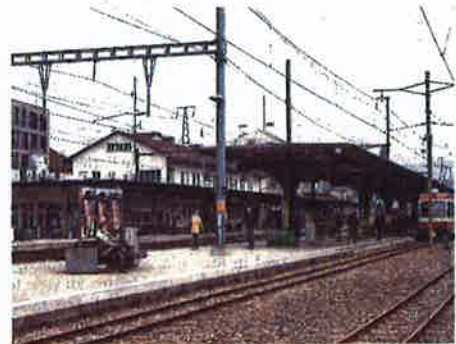
Ab 2019 wird hier der Bau des vierten Gleises ein eigentliches Baustellenchaos auslösen.
