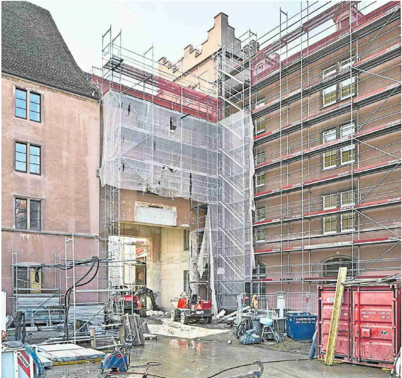
Wo geht es hier zum Rhein? Zwischen Klingentalkirche und Kaserne-Kopfbau gähnt ein riesiges Loch.
